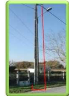
Branchement aéro-souterrain
